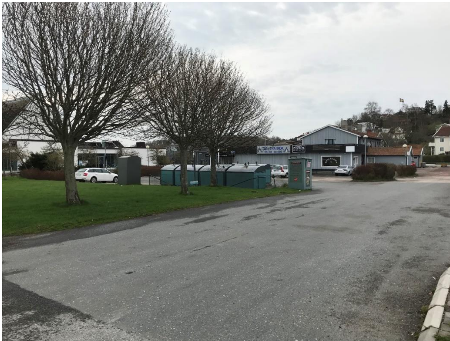
Figur 4. Befintlig bebyggelse inom planområdet. Bild tagen från Hammarvägen i norr
